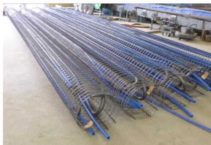
工場で作製した熱交換器と鉄筋かご
