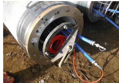
杭中空部に挿入した熱交換器
