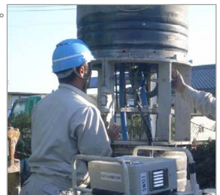
施工試験の様子
